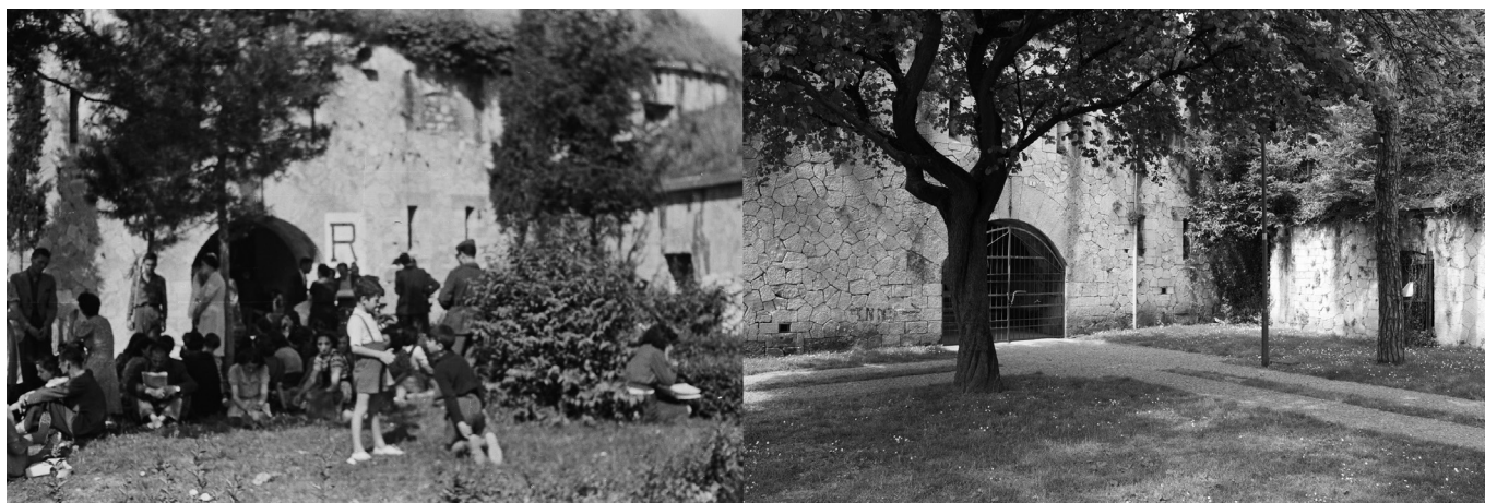
Verona, rifugio contraereo in lungadige San Giorgio (ex lungadige del Littorio), 1944/oggi
